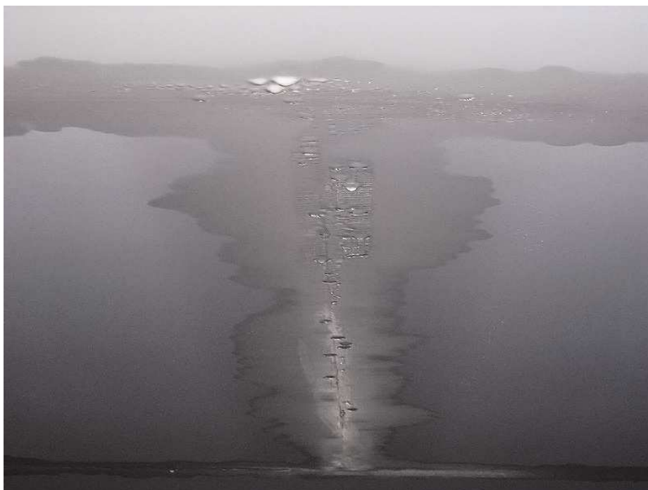
Obr. 1: Průsak vody stropní sádrokartonovou konstrukcí v podzemních garážích
