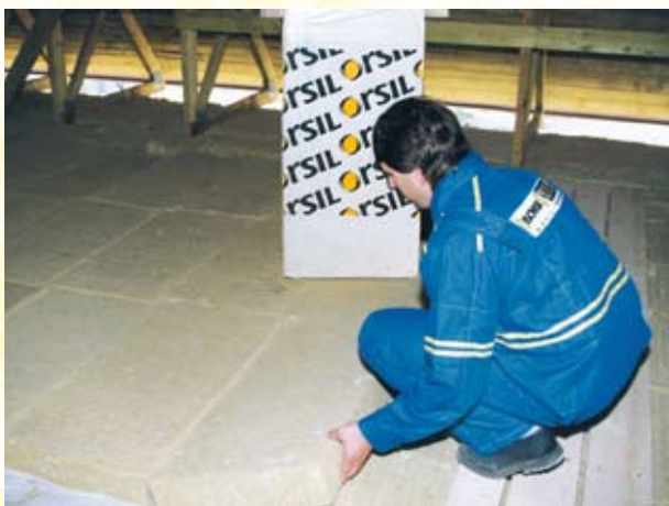
Obr. 1: Ukázka zateplení stropu s použitím výrobku Isover Orstrop
