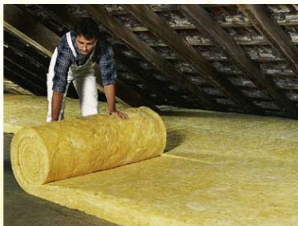
Obr. 2: Ukázka zateplení stropu s použitím výrobku Isover Domo
